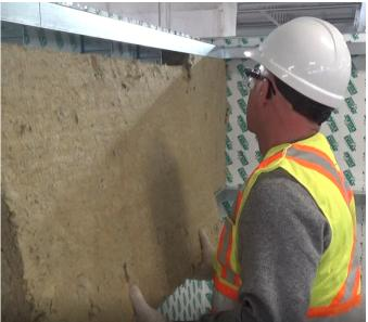
1 Alignez l'isolant avec l'attache « ISO clip » et marquez le bord du clip sur l'isolant.
