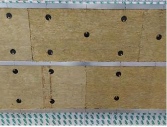
7 Une fois que l'isolant est bien posé et fixé, vous disposez maintenant d'un mur extérieur isolé en continu, prêt à être recouvert.
