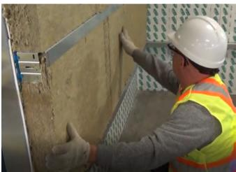
3 Une fois l'isolant coupé, poussez-le entre les profilés d'ossature et assurez-vous que l'isolant est à fleur du mur, sans interférence. Assurez-vous qu'il n'y a pas d'espace entre les isolants et que ceux-ci sont maintenus en place par friction.
