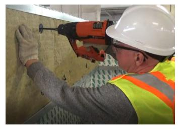
4 Fixez l'isolant au mur à l'aide de fixations pour isolants qui sont fixés à travers les poteaux d'ossature murale ou dans le béton.
