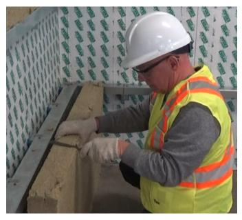
2 À l'aide d'un couteau, coupez l'isolant verticalement pour lui permettre de contourner l'attache.
